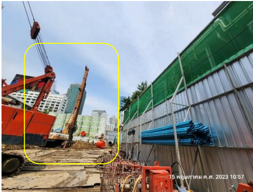
รูปที่ 15 ใช้เสาเข็มแบบเจาะระบบเปียก
