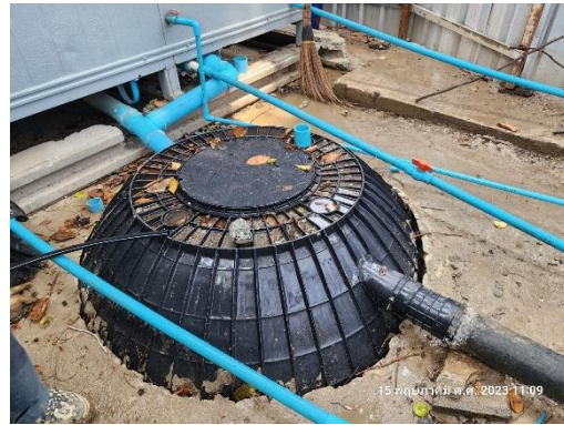
รูปที่ 20 ระบบบำบัดน้ำเสียสำเร็จรูป
